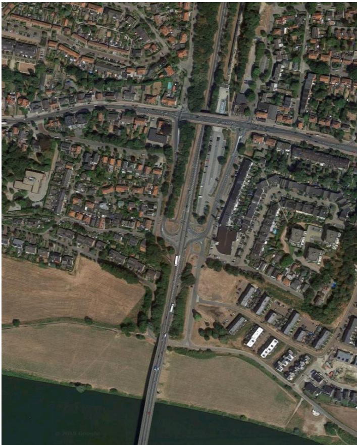
Figuur 2-2 Luchtfoto kruising N225-N233
