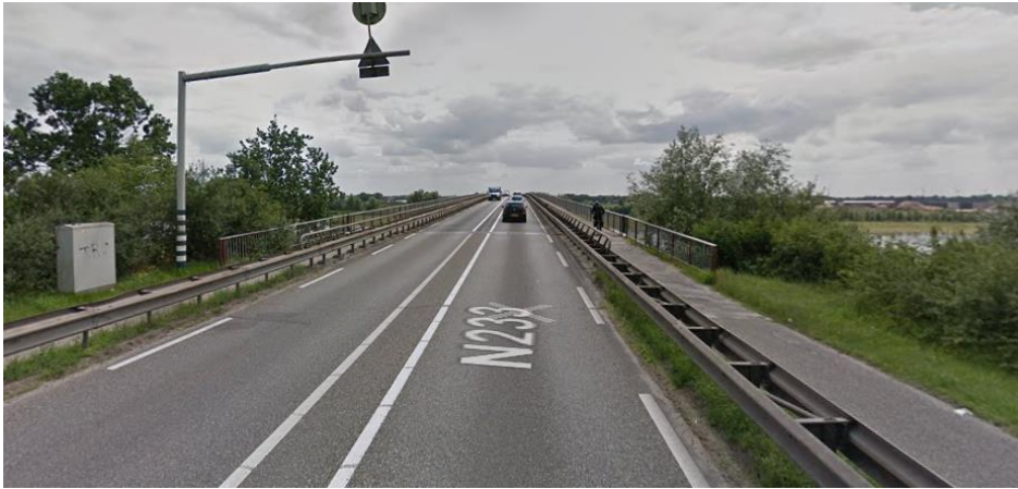
Figuur 4-2 Rijnbrug gezien vanuit Rhenen, met rechts het huidige fietspad (bron: Google Streetview)
