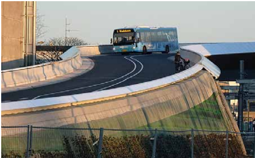
Een hellingbaan vormt een barrière over grote lengte en is daardoor slecht inpasbaar in een stadsstraat.
