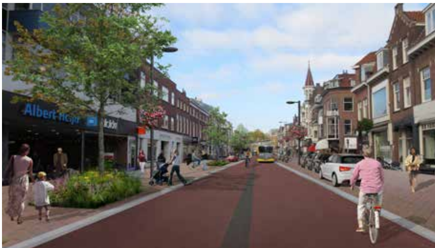
Menging kan veel ruimte besparen. Welke verkeersdeelnemers de ruimte kunnen delen, hangt af van de locatie. Op de Utrechtse Nachtegaalstraat worden fiets, bus en al het overige gemotoriseerde verkeer gemengd (realisatie 2021). Daardoor ontstaan royale groene trottoirs.
