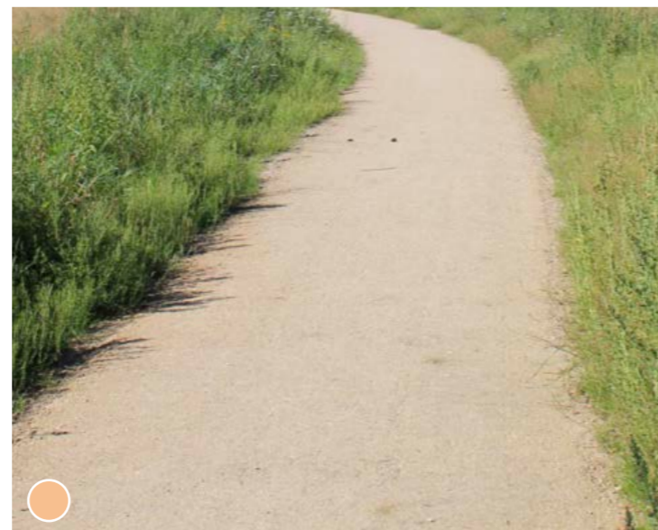
Parkpad - Asphalt met witte afstrooilag
