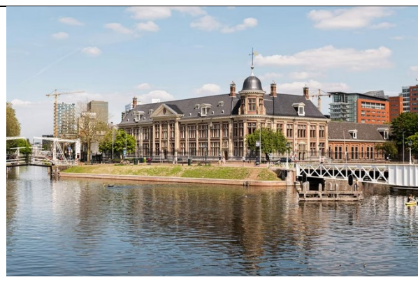
Muntgebouw met Muntbrug in 2021
