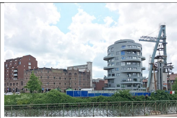
Fabriekskasteel SOL is herbestemd
