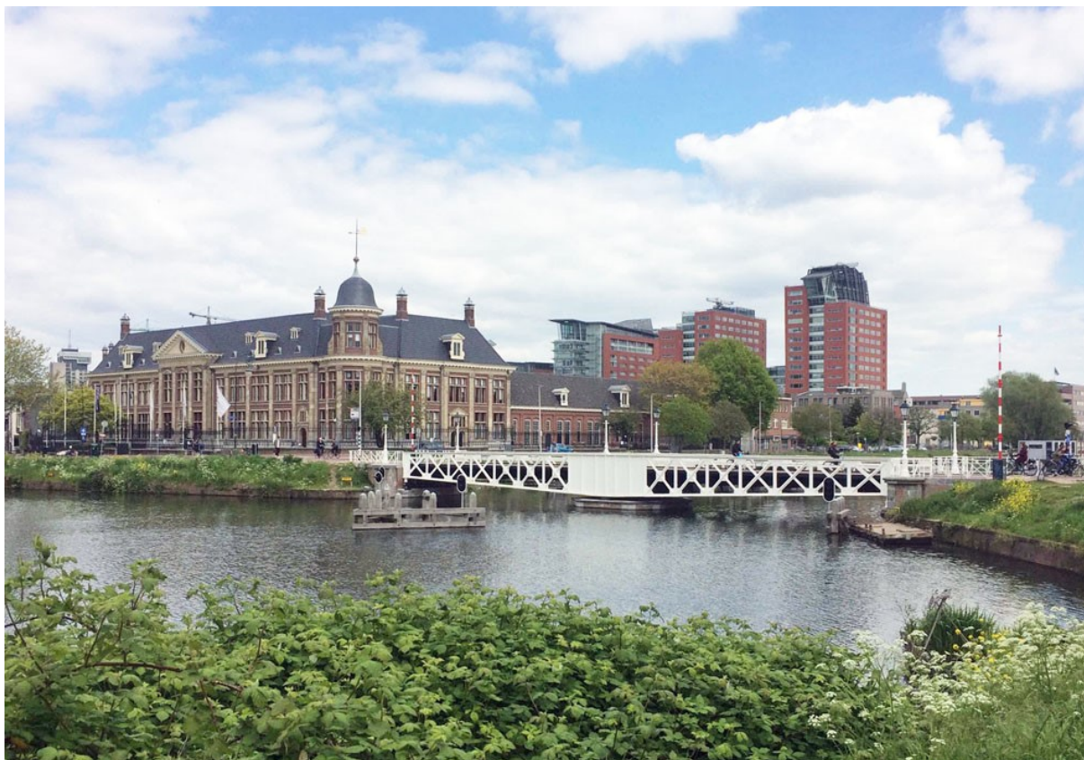
Merwedekanaal met de originele draaibrug, de Muntbrug, bij het gebouw van 's Rijks Munt
