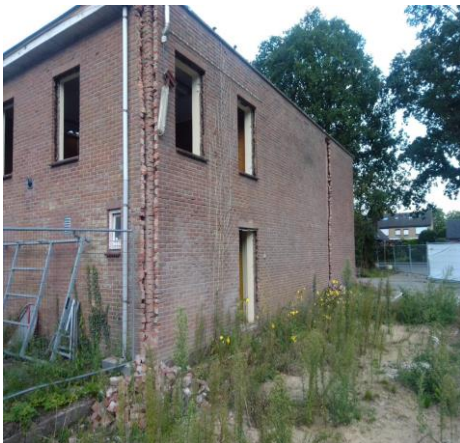
Figuur 3. Ongeschikt maken spouwmuur door het openbreken van de buitenmuur.
