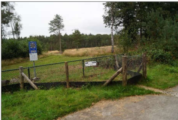
Afbeelding 5.21 | Faunatunnel met rooster onder fietspad Heezerspoor Oostzijde.
