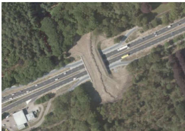
Afbeelding 13.1 | Overzicht ecoduct Beukbergen (hartvandeheuvelrug.nl).
