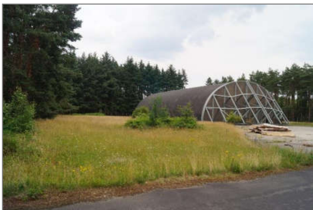
Afbeelding 4.2 | Voormalige hangar op het terrein van vliegbasis Soesterberg met schraal grasland en productiebos.
