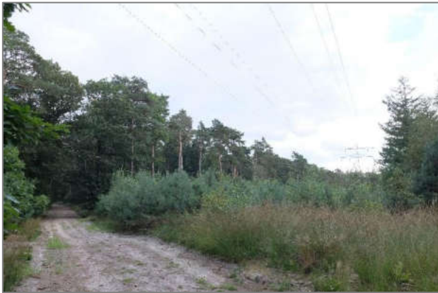
Afbeelding 3.11 | Verjonging onder de hoogspanningsmasten op het terrein van ASR.
