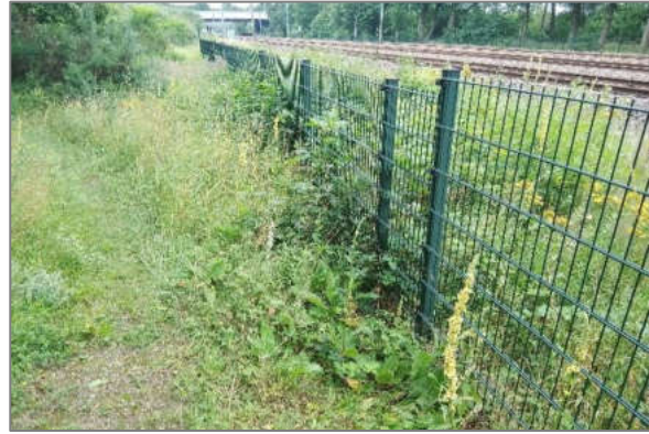
Afbeelding 10.3 | Geleiding langs de spoorlijn.
