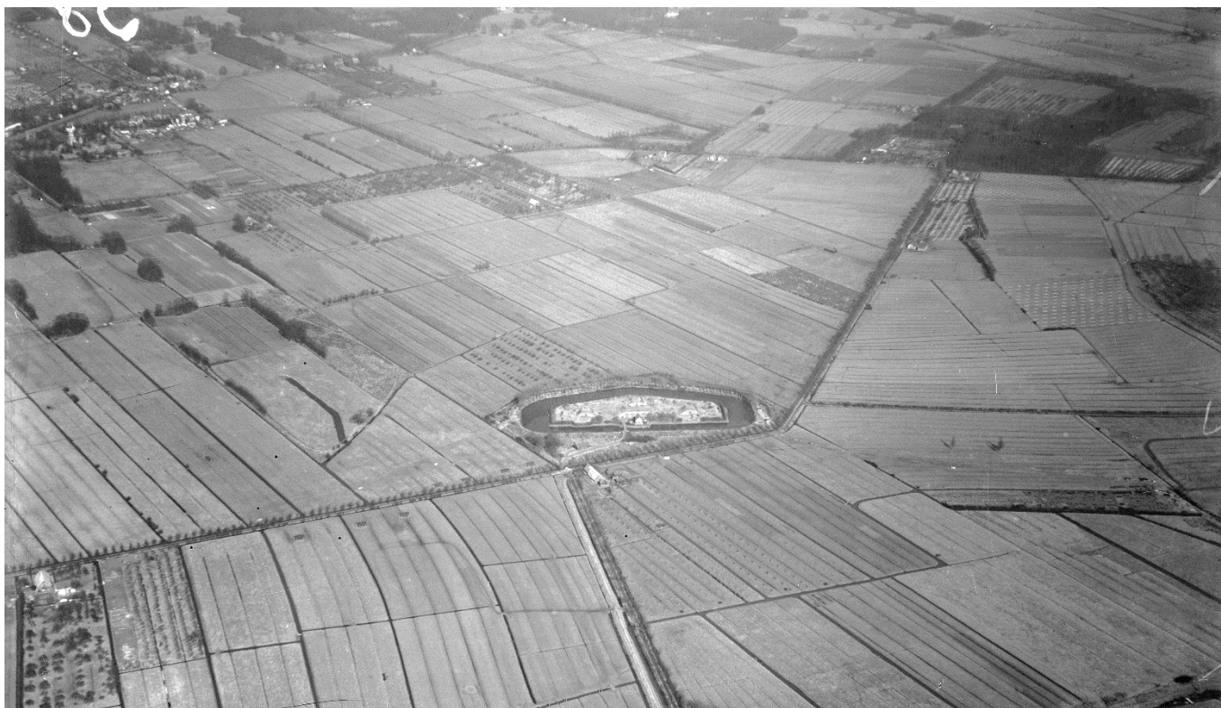
Figuur 3-4 Luchtfoto vanuit het zuidwesten. Werk aan de Hoofddijk (midden), de Hoofddijk (gearceerd) en Landhuis Oostbroek (rechtsboven). Circa 1920 - 1940 (bron: Collectie Nederlands Instituut voor Militaire Historie)
