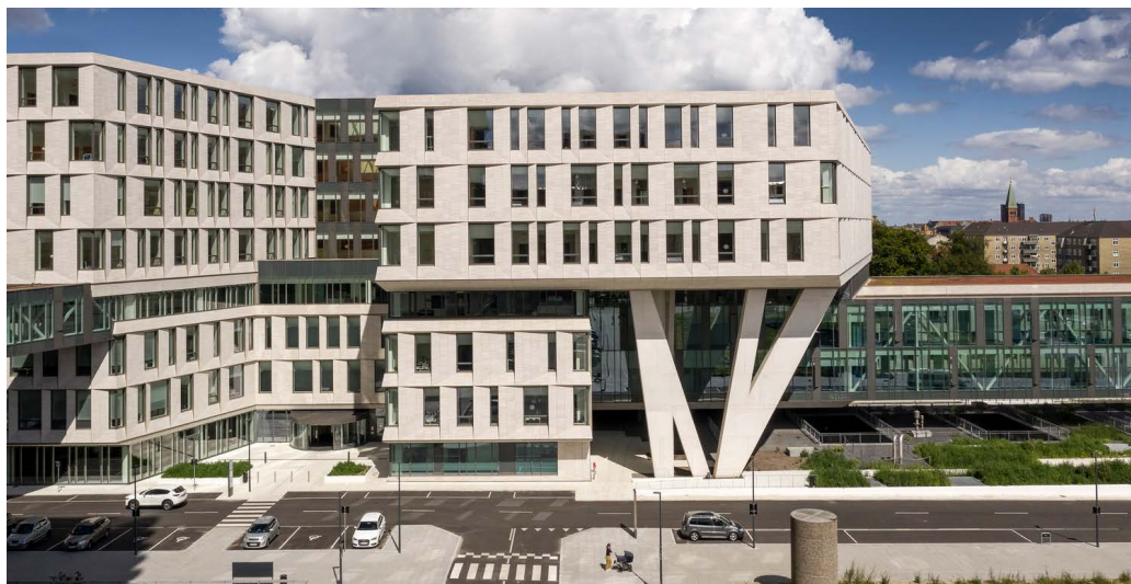
Rigshospitalet Hospital North Wing - Copenhagen (LINK arkitektur + 3XN, foto: Adam Mørk)
