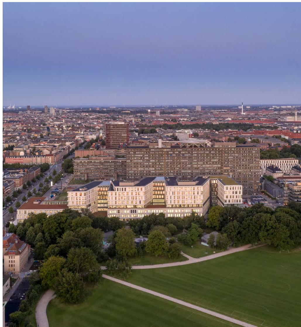
Rigshospitalet Hospital North Wing - Copenhagen (LINK arkitektur + 3XN, foto: Adam Mørk)
