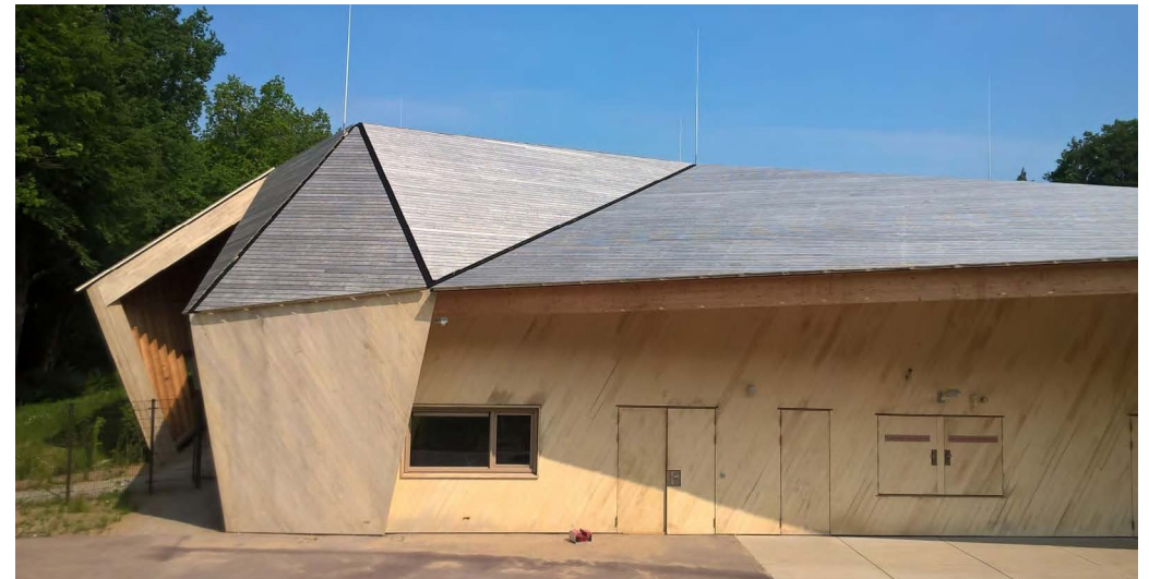
Kapconstructie Vitens van Heek - Zeddam (Roeding Architecten)
