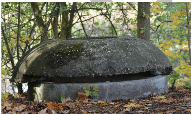
Betonnen mangat – waarnemingspost. Deze waren in de opzet geïntegreerd in loopgraven. Zeldzaam exemplaar.
