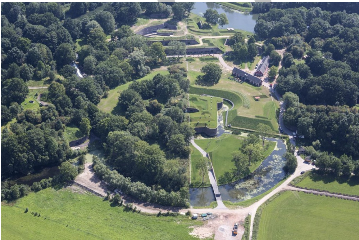
Fort bij Vechten – Bunnik – Kruispunt met de Limes en imposant iconisch bouwwerk
