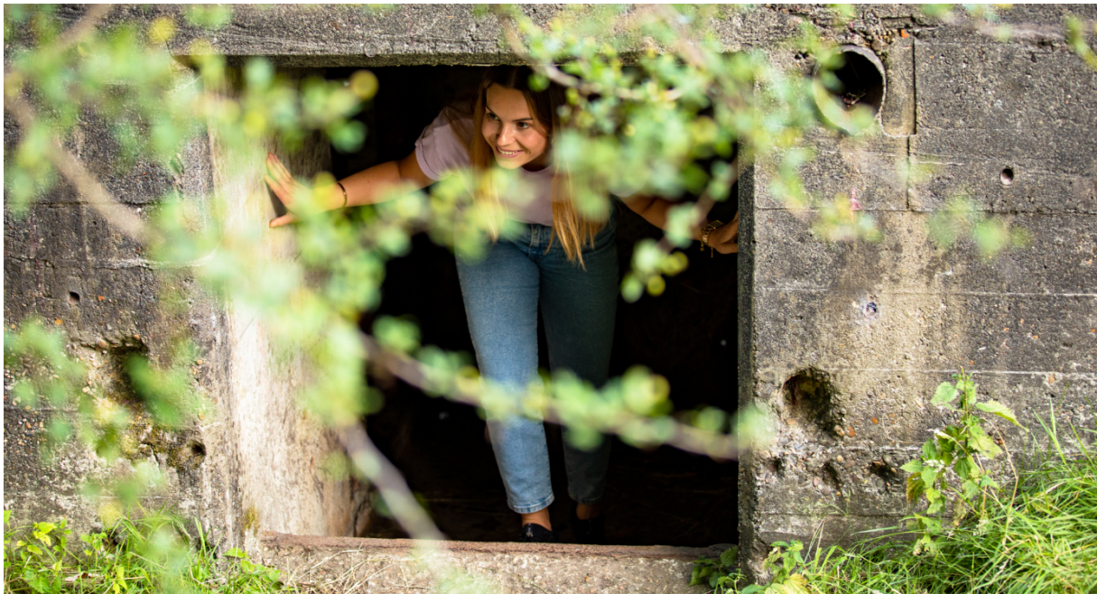
Fort aan de Klop – Utrecht - Groepsschuilplaats
