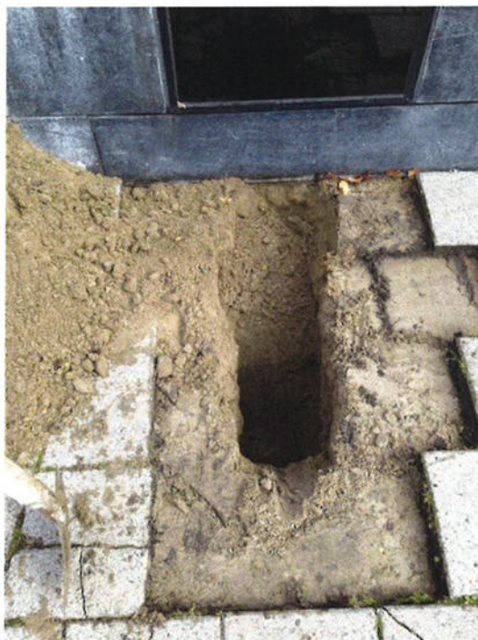
Figuur 3: Proefsleuf locatie 2
