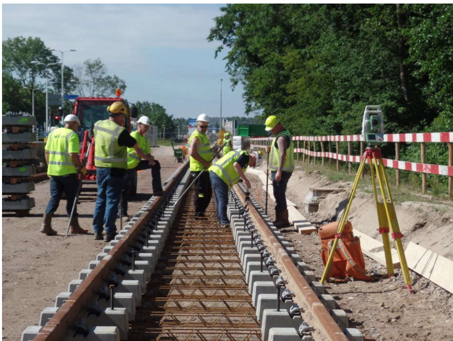
Aanleg spoor aan de Laan van Maarschalkerweerd (foto: E. Warmer)
