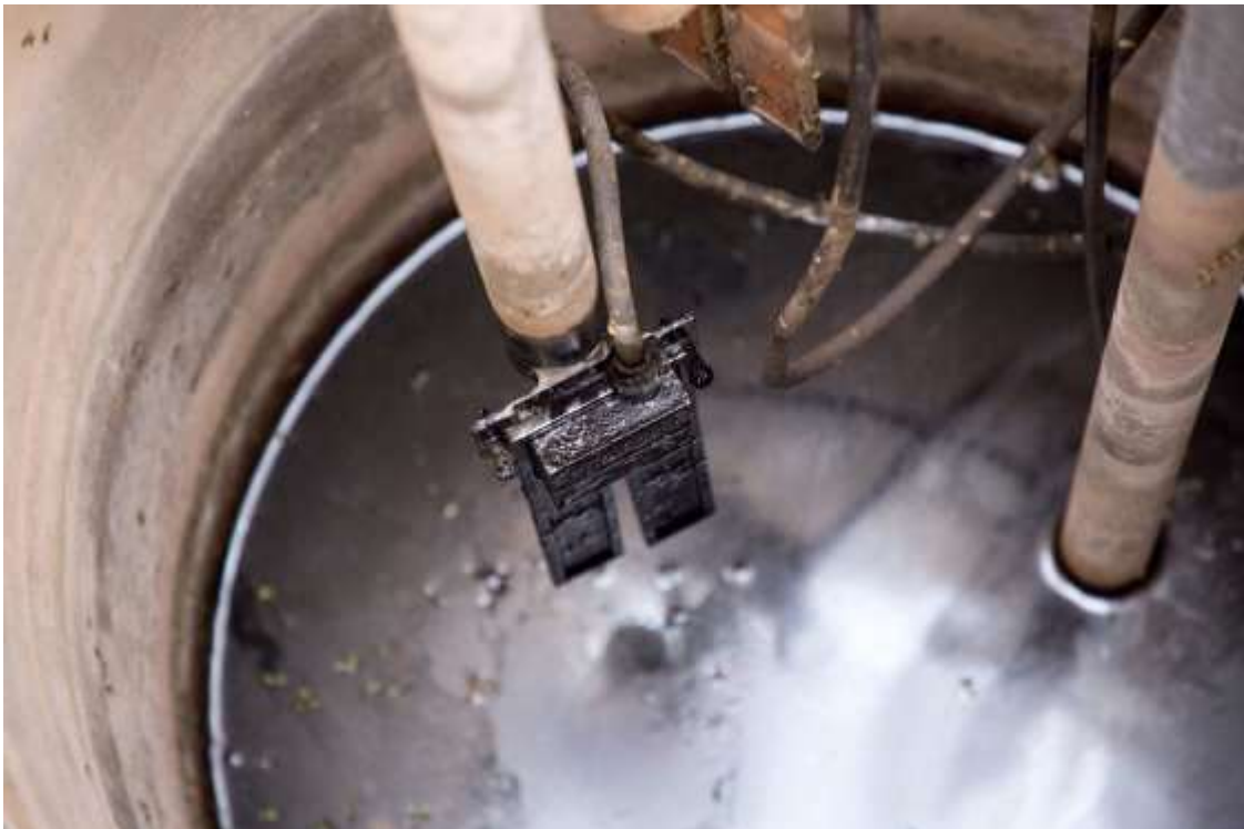
• De meetsonde in de pomp is voor de foto even naar boven gehaald.
