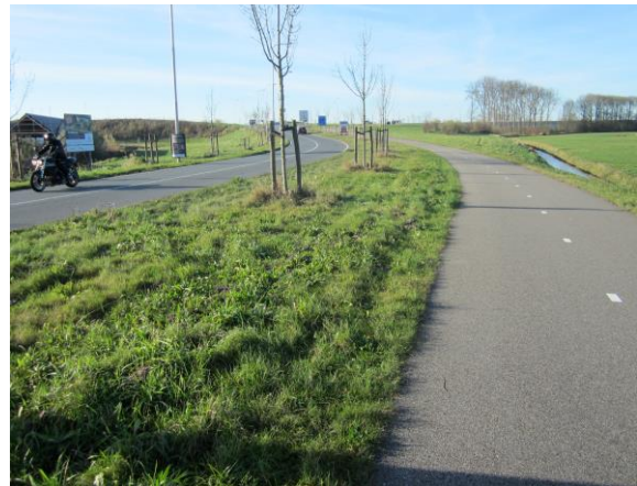
Foto 4: tussenberm rijbaan en (brom-) fietspad
