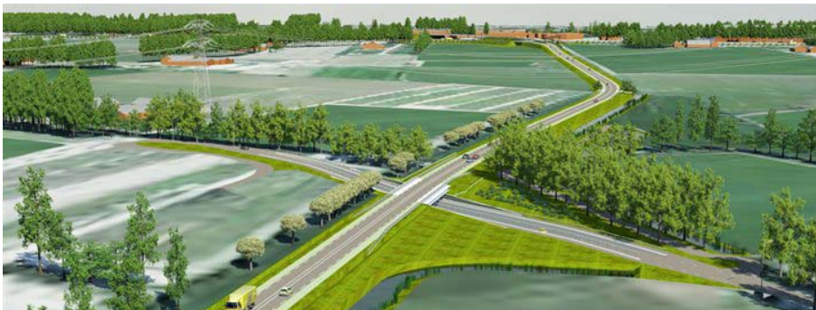
1 A12 Aanleg verbindingsweg Houten - Bunnik - A12: ongelijkvloerse kruising Achterdijk
