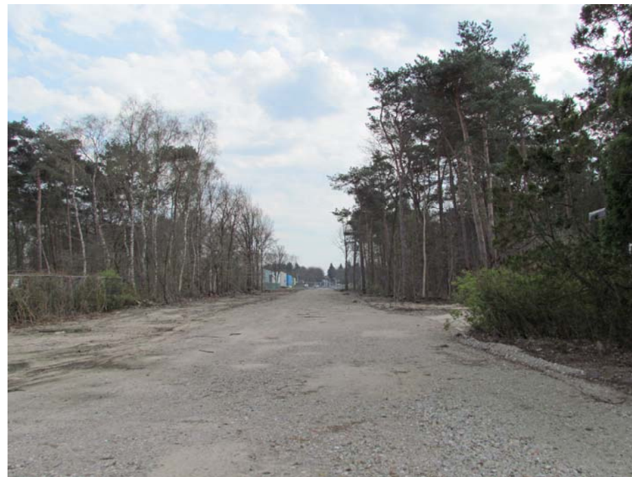
Eind 2016/begin 2017 is het tracé van de WOS over de vliegbasis voorzien van een halfverharding van steenslag, 31 maart 2017 (HV)
