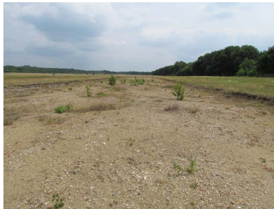
Grote delen van het cunet van de verwijderde zuidelijke rolbaan zijn ruim vijf jaar na het weghalen van de verharding nog vrijwel onbegroeid, 23 juni 2017 (HV)
