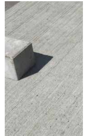
Geborsteld beton - Woonstraat Heidewonen
