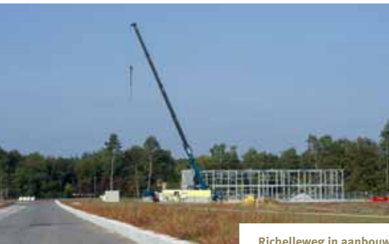
Richelleweg in aanbouw
