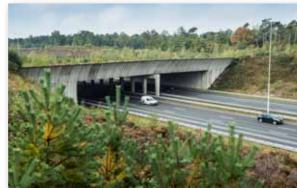
ECODUCT LEUSERHEIDE A28 | Wie: Rijkswaterstaat Wat: ecoduct over de A28 als onderdeel van de oostelijke groene corridor. Status: opgeleverd in 2005
