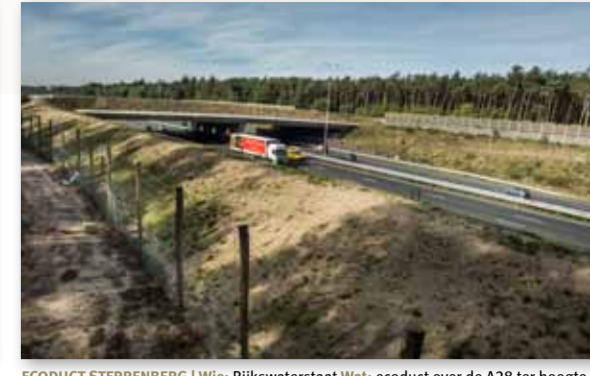
ECODUCT STERRENBERG | Wie: Rijkswaterstaat Wat: ecoduct over de A28 ter hoogte van Huis ter Heide als onderdeel van de westelijke groene corridor. Status: opgeleverd in 2012
