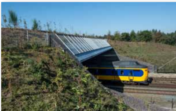
ECODUCT OP HEES | Wie: ProRail Wat: sporecoduct op de plek waar de oostelijke en westelijke corridor samenkomen. Het ecoduct maakt een verbinding tussen het midden en noorden van de Utrechtse Heuvelrug mogelijk voor diverse diersoorten en is ook voor fietsers en voetgangers bedoeld. Status: opgeleverd in 2013
