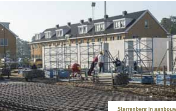
Sterrenberg in aanbouw
